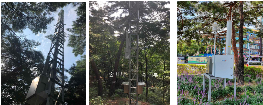
< 미세먼지 저감 측정장비 설치 사례 >
