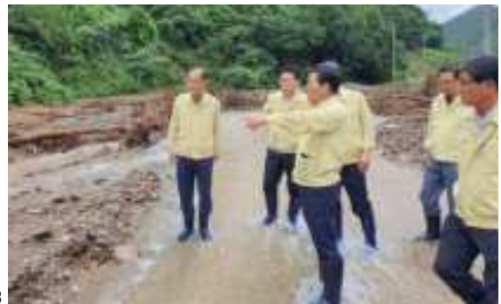
01 괴산 연풍면 제방 및 제방도로 붕괴
