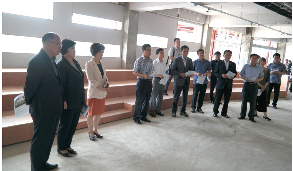
교육위원회는 7월 14일 2017년 9월 개원 예정인 (구)주성중학교에 위치한 충청북도진로교육원 공사 현장을 방문해 현황을 보고 받고 현장을 점검했다.
