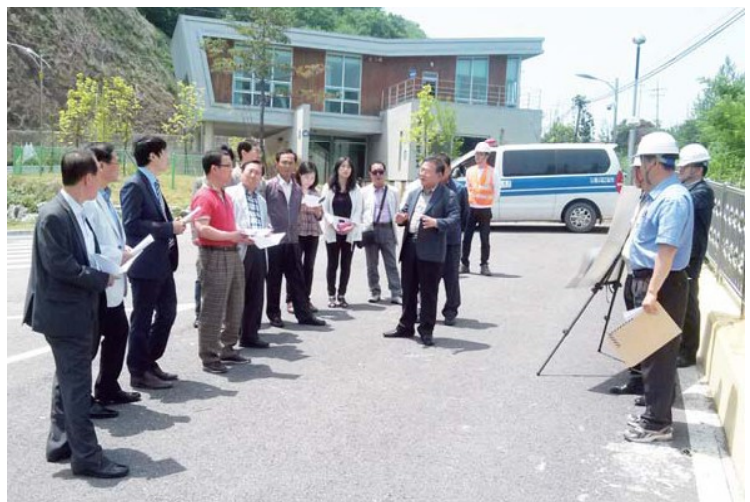
△ 충청북도의회 결산검사위원들이 5월 27일 제천에 위치한 연금리조트~청풍대교 간 도로 확포장 공사장에 대한 현지확인을 실시했다.
